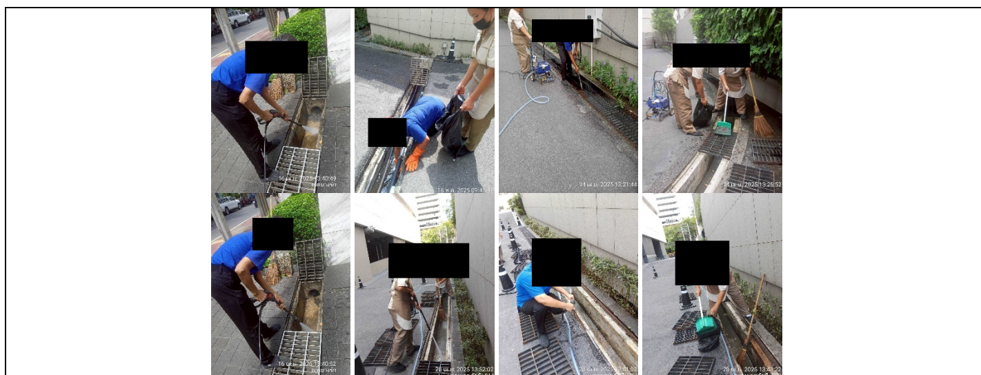
รูปที่ ผ7.39 เจ้าหน้าที่ทำความสะอาดตะกอนดิน และใบไม้ต่างๆออกจากท่อระบายน้ำ
