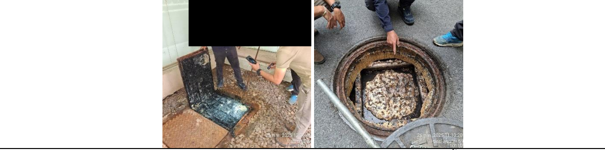
รูปที่ ๗.12 เจ้าหน้าที่กำจัดไขมันออกจากบ่อดักไขมันในระบบบำบัดน้ำเสีย
