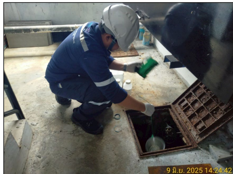
รูปที่ 3.3 การเก็บตัวอย่างน้ำทิ้ง
