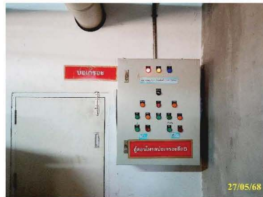
ตู้ควบคุมบ่อเกรอะอาคาร B
