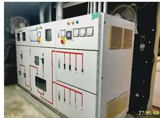
ตู้ควบคุมระบบไฟฟ้าหลักอาคาร A
