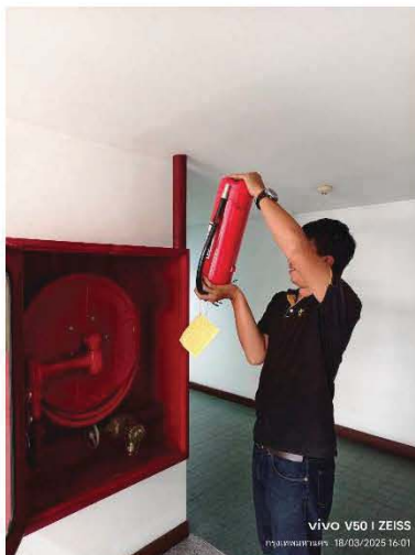
ช่างตรวจเช็ค และบำรุงรักษาอุปกรณ์ป้องกันและแจ้งเหตุเพลิงไหม้
