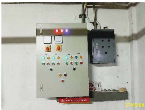
ตู้ควบคุมระบบบำบัดน้ำเสียรวม
