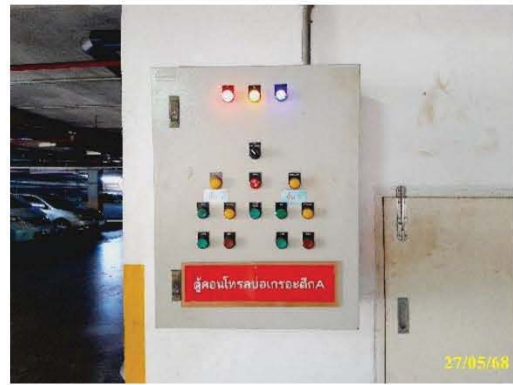
ตู้ควบคุมบ่อเกรอะอาคาร A
