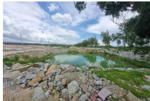
บ่อดักตะกอนเพื่อรองรับน้ำจากท่าเหมือง
