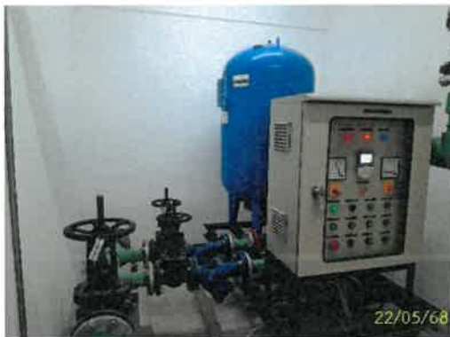
เครื่องสูบน้ำใช้ชั้นคาตฟ้า อาคาร A
