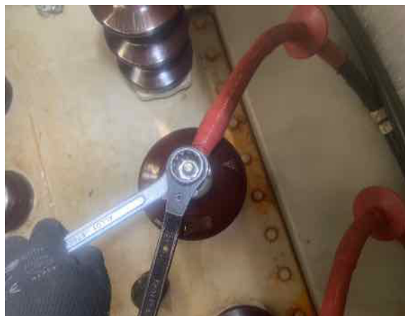
ชั้นอัดข้อต่อสายไฟฟ้าด้านแรงสูง
