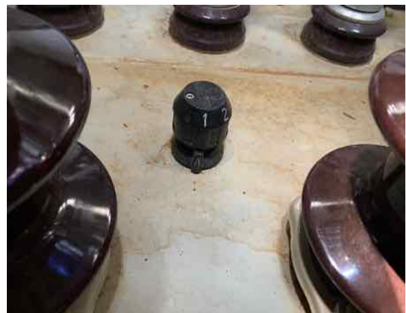
ตำแหน่งที่ปรับแรงดัน : Tap Changer
