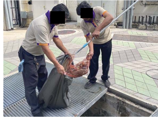
การทำความสะอาดและตักเศษขยะออกจากตะแกรงดักขยะ
