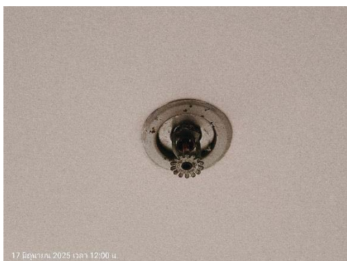
หัวกระจายน้ำดับเพลิง (Sprinkler System)
