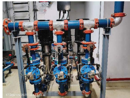
เครื่องสูบน้ำ Reuse
