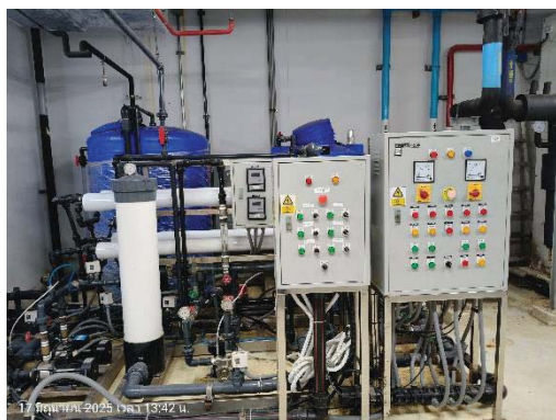
ระบบปรับคุณภาพน้ำสำหรับระบบปรับอากาศ
