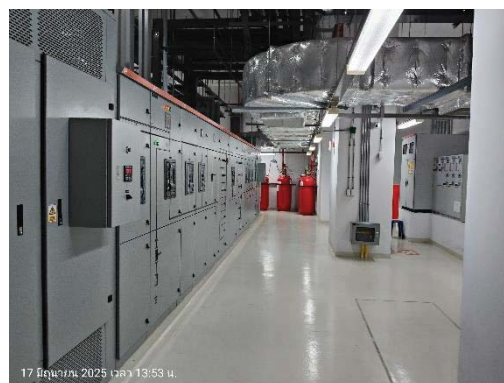
ระบบไฟฟ้าหลักหม้อแปลงไฟฟ้าและ MDB
