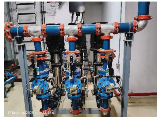
เครื่องสูบน้ำ Reuse
