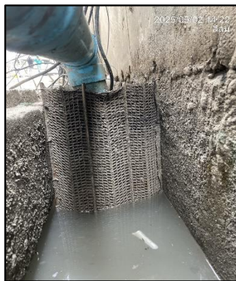
รูปที่ 43 ตะแกรงดักขยะก่อนระบายน้ำออกจากโครงการ
