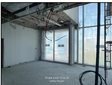
รูปที่ 22 กำแพงกันเสียงติดตามชั้นอาคารที่กำลังก่อสร้าง และการใช้กระจกจริงตามชั้นอาคาร
