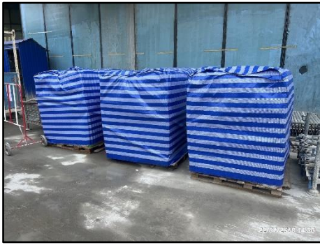
รูปที่ 60 การปิดคลุมวัสดุก่อสร้างด้วยผ้าใบเพื่อป้องกันฝุ่นฟุ้งกระจาย
