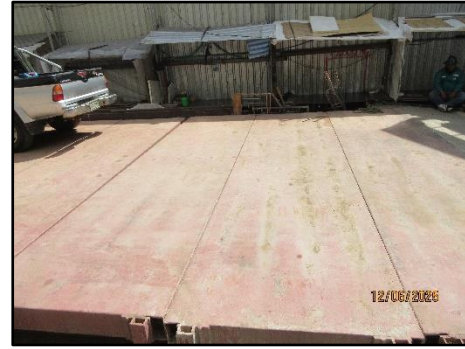
รูปที่ 69 แผ่นเหล็กลักษณะหนาปูให้ทั่วบริเวณที่มีรถวิ่งผ่านภายในพื้นที่ก่อสร้าง
