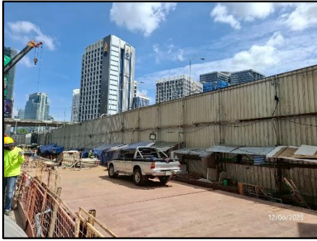
รูปที่ 69 แผ่นเหล็กลักษณะหนาปูให้ทั่วบริเวณที่มีรถวิ่งผ่านภายในพื้นที่ก่อสร้าง
