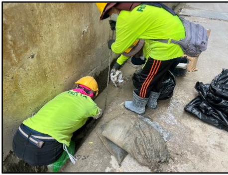
รูปที่ 42 การทำความสะอาดบ่อดักตะกอนดิน
