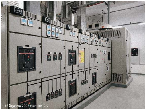
หม้อแปลงไฟฟ้าชนิด Dry Type ขนาด 2,500 KVA จำนวน 2 ชุด
