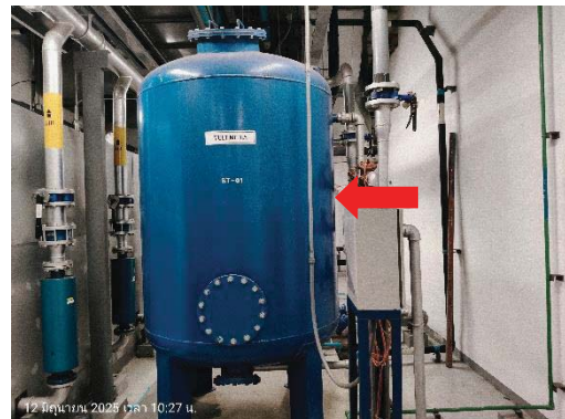
ระบบกรองน้ำฝนเพื่อทำเป็นน้ำ REUSE
