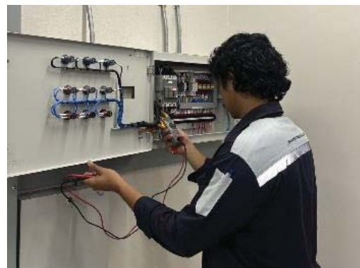
เจ้าหน้าที่ตรวจสอบพัดลมอัดอากาศ
