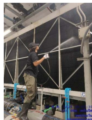
ระบบสำหรับควบคุมเชื้อลิโอเนลลาในหอผึ่งเย็น
