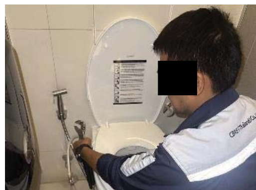
เจ้าหน้าที่ตรวจสอบสุขภัณฑ์ไม่ให้เกิดการรั่วไหล
