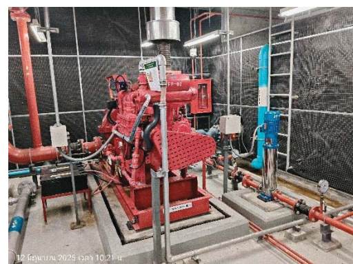
Fire Pump & Jockey Pump ชั้น 11 M
