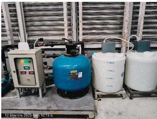
ระบบสำหรับควบคุมเชื้อลิโอเนลลาในหอผึ่งเย็น
