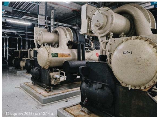
ระบบปรับอากาศแบบ Water Cooled Chiller
