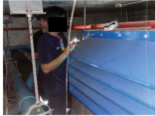
ตรวจสอบระบบ UV ที่ดูดอากาศจากระบบบำบัดน้ำเสีย เปลี่ยน ถ่าน Activated Carbon ระบบบำบัด Aerosol
