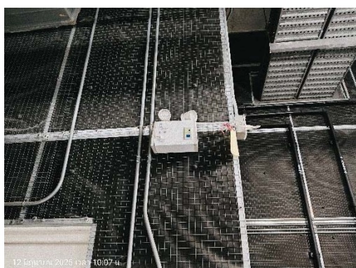
ห้องควบคุมด้วยวัสดุดูดซับเสียงและไฟฉุกเฉิน
