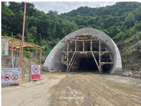
งาน Lining Arch Wall
