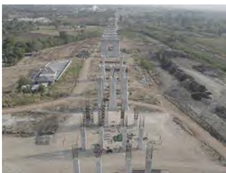
งานติดตั้ง Pier และ Abutment
