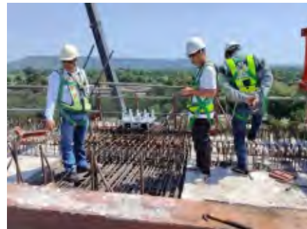
งาน Balance cantilever (เทคอนกรีต, งานเลื่อน Form Segment, งานผูกเหล็ก, งานติดตั้งเหล็ก)
