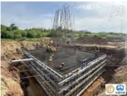
งานโครงสร้างทางวิ่งยกระดับ (Pile Cap Column, Pier Column และ Pile cap)
