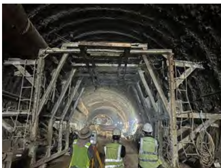
ภาพที่ 3.2.1-1 การตรวจวัดการทรุดตัวจากกิจกรรมการก่อสร้างอุโมงค์
