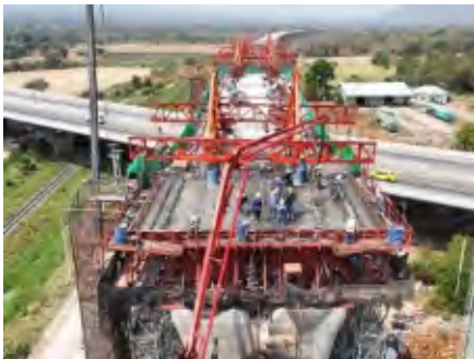
งาน Balance cantilever (เทคอนกรีต, งานเลื่อน Form Segment, งานผูกเหล็ก, งานติดตั้งเหล็ก)
