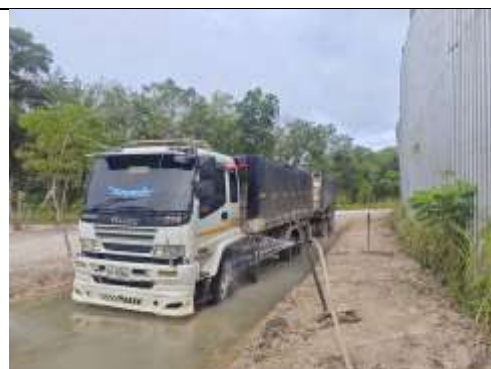
รูป AB บ่อล้างล้อรถบรรทุกและการล้างล้อรถบรรทุก
