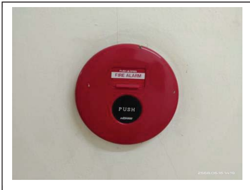
รูปที่ 2.14-8 อุปกรณ์แจ้งเหตุเพลิงไหม้ ด้วยมือ
