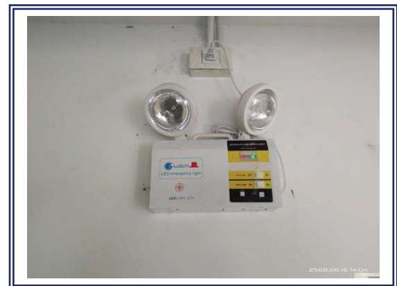
รูปที่ 3.1-53 ไฟส่องสว่างฉุกเฉิน
