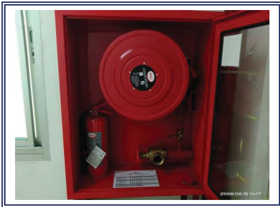
รูปที่ 3.1-52 ถังดับเพลิงแบบมือถือในตู้สายฉีดน้ำดับเพลิง
