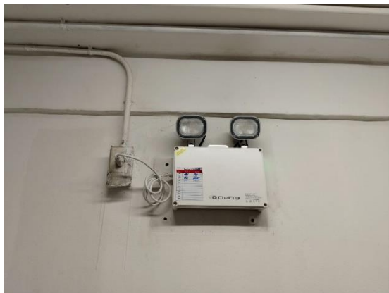
รูปที่ 35 ระบบไฟฟ้าแสงสว่างฉุกเฉิน
