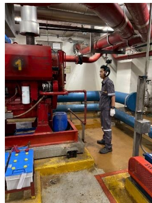
รูปที่ 42 ทดสอบการทำงานของเครื่องสูบน้ำ
