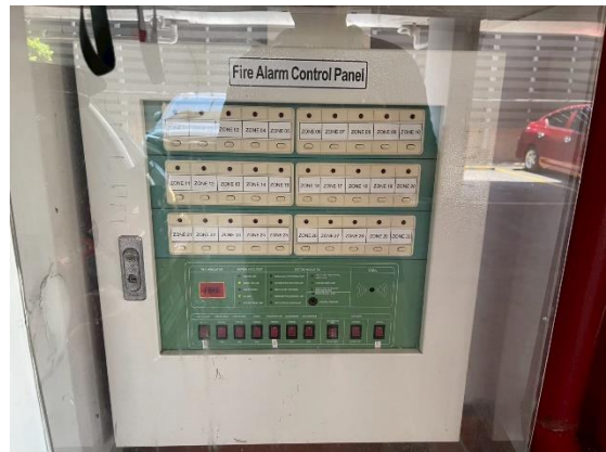
รูปที่ 19 แผงควบคุม (Fire Alarm Control Panel : FCP)
