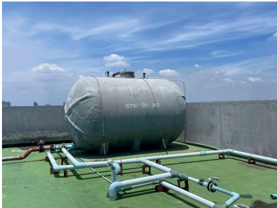
รูปที่ 48 ถังเก็บน้ำชั้นดาดฟ้า
