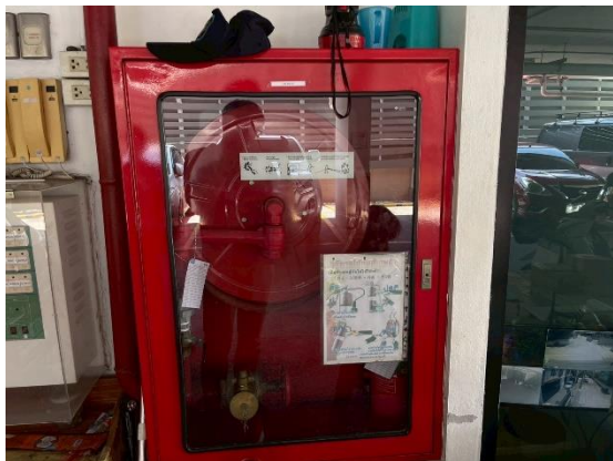
รูปที่ 22 ตู้เก็บสายฉีดน้ำดับเพลิงพร้อมอุปกรณ์
