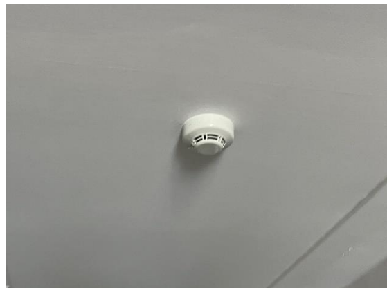
รูปที่ 21 เครื่องตรวจจับควัน
