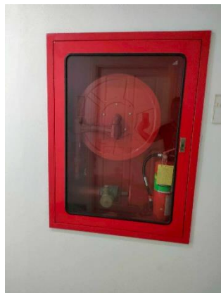
รูปที่ 30 ตู้หัวฉีดดับเพลิง และหัวต่อสายฉีดน้ำดับเพลิง ชนิดเชื่อมต่อสวม
