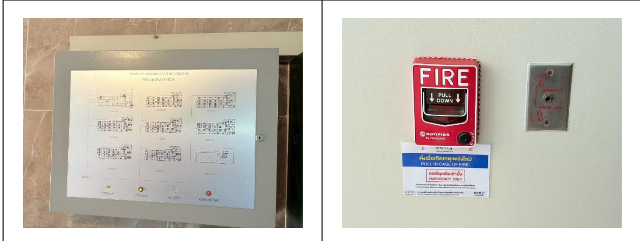
รูปที่ 15 แผงควบคุมระบบสัญญาณแจ้งเหตุเพลิงไหม้
