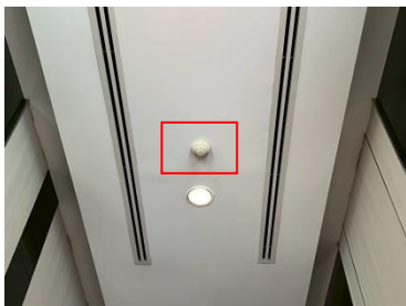
รูปที่ 2-34 เครื่องตรวจจับความร้อน (Heat Detector)
