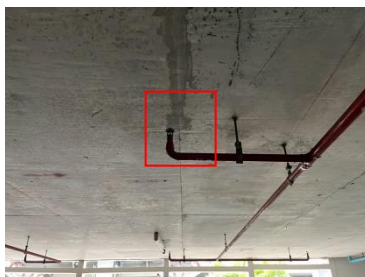
รูปที่ 2-29 ติดตั้งระบบหัวกระจายน้ำ ดับเพลิงอัตโนมัติ (Sprinkler System)
