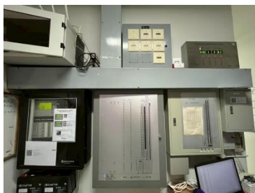
รูปที่ 2-32 แผงควบคุม (Fire Alarm Control Panel: FCP)
