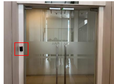
รูปที่ 2-42 ติดตั้งระบบการควบคุม ประตูอัตโนมัติ (Access Control)
