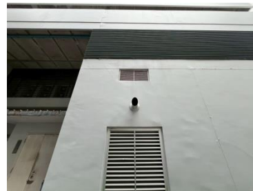
รูปที่ 2-24 ต่อก่อระบายไอเสียจากห้อง เครื่องกำเนิดไฟฟ้า
