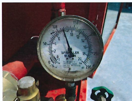
ความดันที่ตำแหน่งเชื่อมต่อตัวไกลสุด ที่ 120 psi
