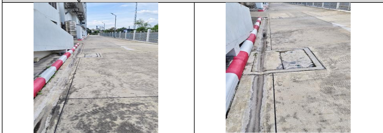
รูปที่ 2-24 รางรวบรวมน้ำเสียจากห้องพักขยะไปยังระบบบำบัดน้ำเสีย
