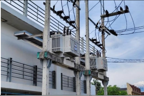
รูปที่ 2-18 การติดตั้งหม้อแปลงไฟฟ้าของโครงการ และ การติดตั้งเครื่องกำเนิดไฟฟ้า
