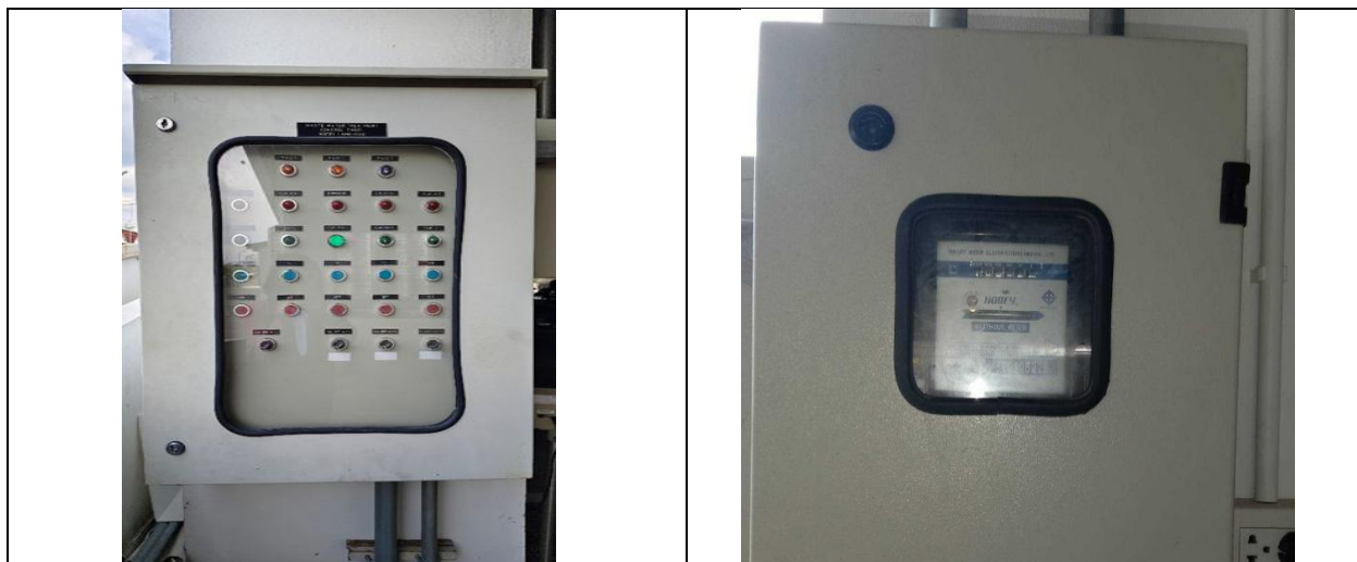
รูปที่ 2-9 การติดตั้งระบบควบคุม และมิเตอร์ไฟฟ้าสำหรับระบบบำบัดน้ำเสีย
