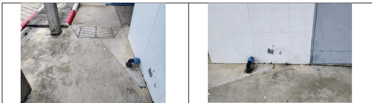
รูปที่ 2-24 รางรวบรวมน้ำเสียจากห้องพักขยะไปยังระบบบำบัดน้ำเสีย
