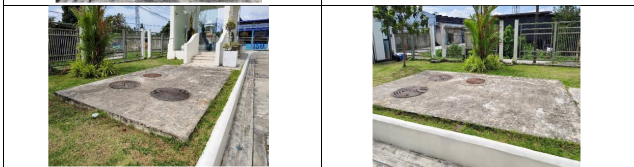
รูปที่ 2-25 บ่อหน่วงน้ำ และระบบระบายน้ำที่ได้รับการดูแล ไม่มีตะกอนอุดตัน
