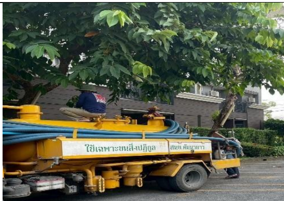
รูปที่ 2-8 การสูบน้ำจากตะกอนจากถังกรองของระบบบำบัดน้ำเสีย
