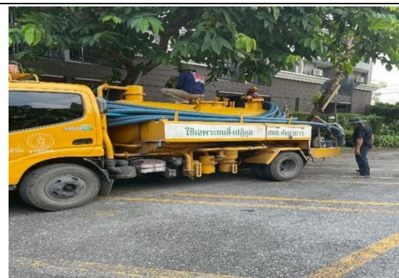
รูปที่ 2-8 การสูบน้ำจากตะกอนจากถังกรองของระบบบำบัดน้ำเสีย
