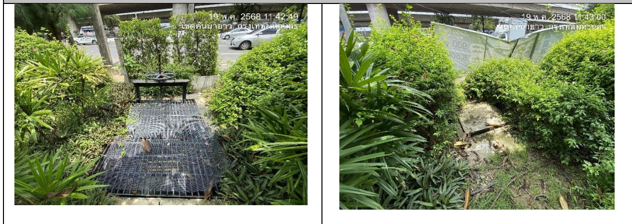
รูปที่ 2-22 ตะแกรงดักขยะ และประตูระบายน้ำก่อนออกจากโครงการ
