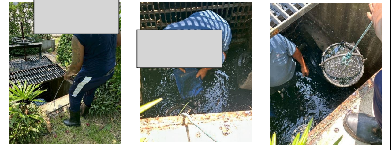
รูปที่ 2-24 การขุดลอก ทำความสะอาดทางระบายน้ำ ภายในโครงการ และที่เชื่อมภายนอกโครงการ
