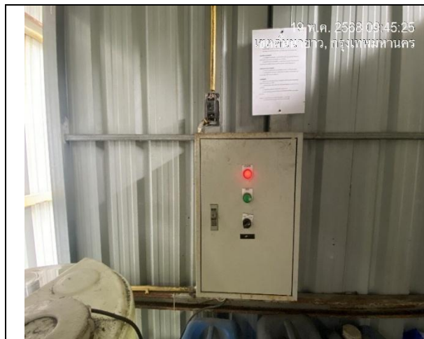
รูปที่ 2-9 การติดตั้งตู้ควบคุมไฟฟ้าระบบบำบัดน้ำเสีย
