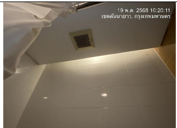
รูปที่ 2-31 การติดตั้งพัดลมระบายอากาศในห้องพักและในห้องน้ำ
