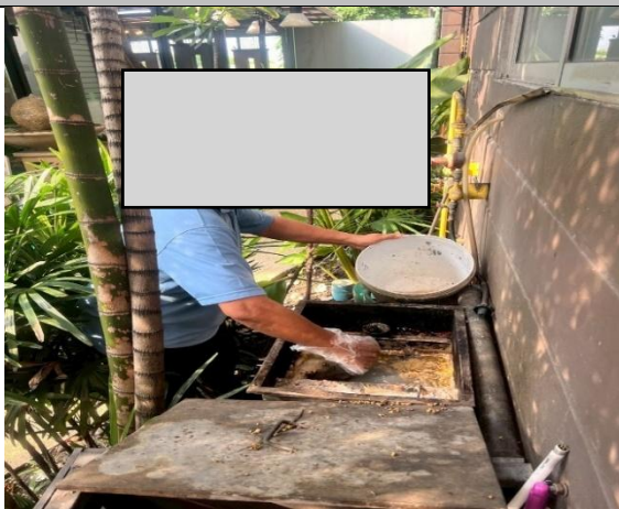
รูปที่ 2-7 การตัดไขมันจากบ่อดักไขมันเพื่อนำไปกำจัด
