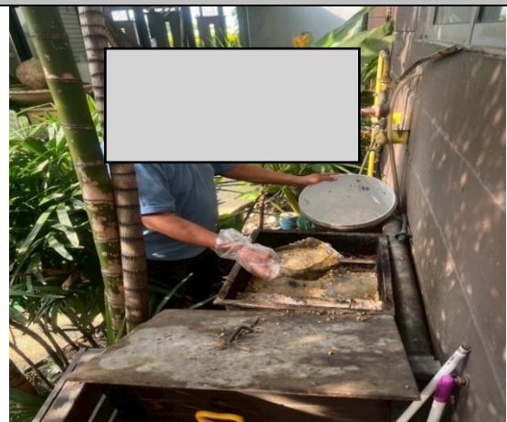
รูปที่ 2-7 การตัดไขมันจากบ่อดักไขมันเพื่อนำไปกำจัด
