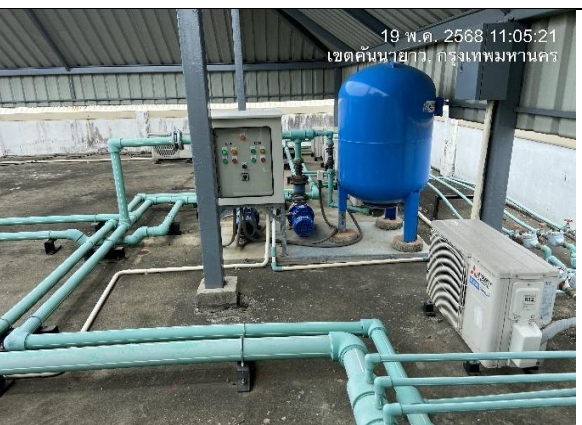
รูปที่ 2-11 ระบบจ่ายน้ำประปา ถังน้ำสำรอง และการดูแลระบบน้ำประปาให้อยู่ในสภาพดี
