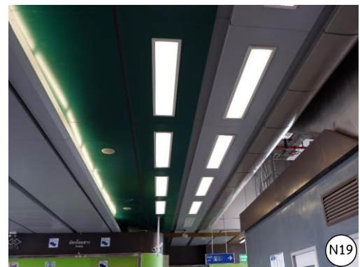
รูปที่ 2-9 การติดตั้งไฟส่องสว่างบริเวณใต้สถานีและด้านข้างริมทางเดินเท้า
