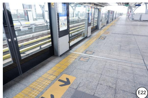
รูปที่ 2-18 แนวเส้นสีเหลืองและพื้นผิวขรุขระแสดงเขตห้ามลงล่าง
