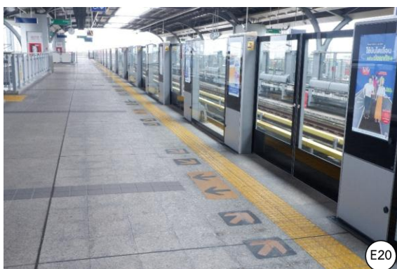
รูปที่ 2-18 แนวเส้นสีเหลืองและพื้นผิวขรุขระแสดงเขตห้ามลงล่าง
