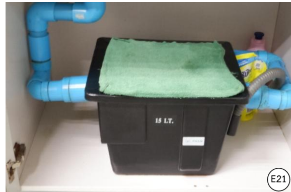
รูปที่ 2-1 การติดตั้งถังดักไขมันในห้องพักพนักงาน
