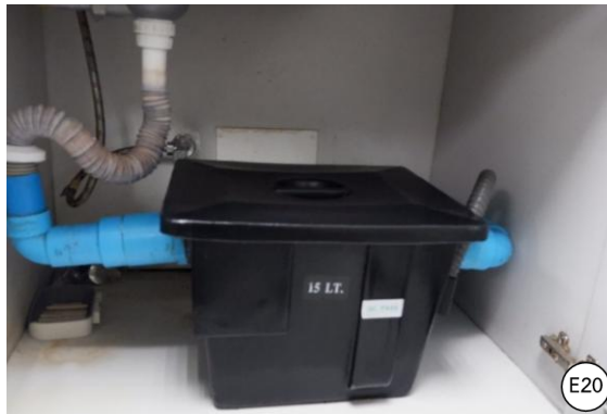
รูปที่ 2-1 การติดตั้งถังดักไขมันในห้องพักพนักงาน
