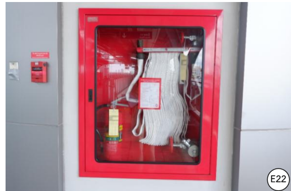
รูปที่ 2-17 การติดตั้งอุปกรณ์ดับเพลิง
