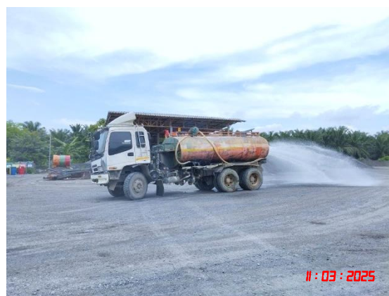
รูปที่ 13 การฉีดพรมน้ำในพื้นที่โครงการ
