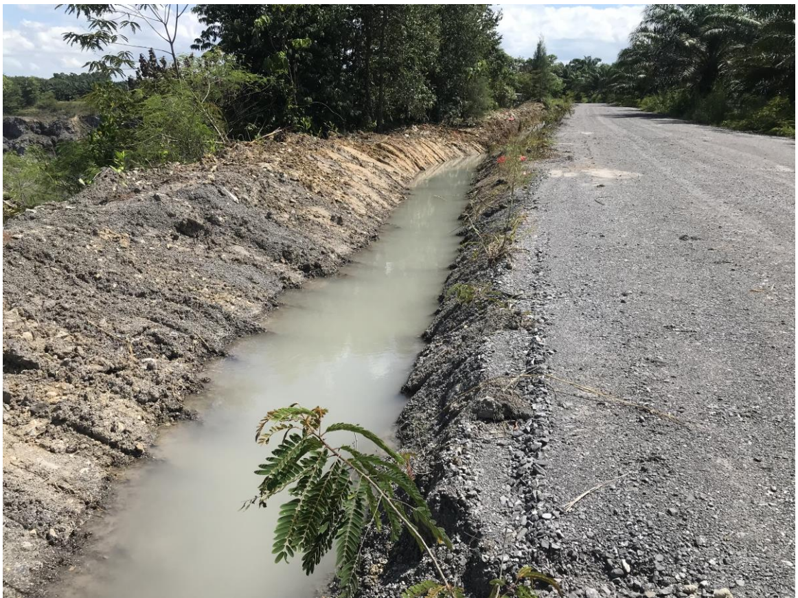
ภาพที่ 8 คูระบายน้ำรอบบ่อเหมือง
