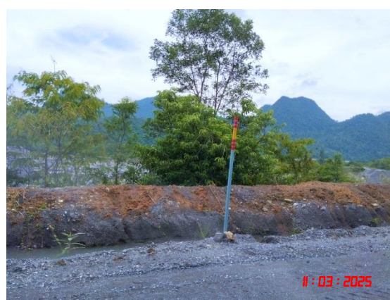
รูปที่ 3 คั่นทำนบดิน และคูระบายน้ำ
