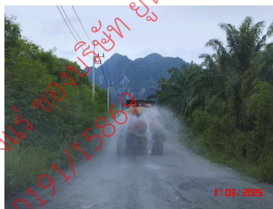
รูปที่ 14 ระบบป้องกันผลกระทบสิ่งแวดล้อมบริเวณโรงโม่บด และย่อยหิน
