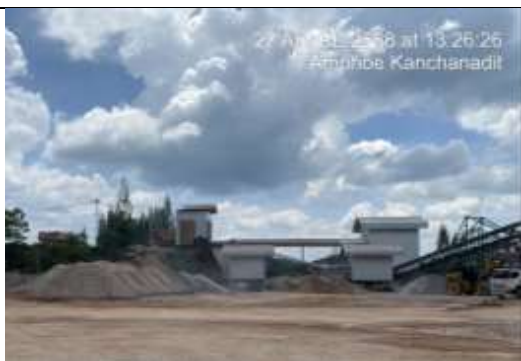
รูป Q สร้างอาคารปิดคลุม Hopper, Primary Crusher และตระแกรงคัดขนาดแร่ พร้อมทั้งติดตั้งระบบสเปรย์น้ำ
