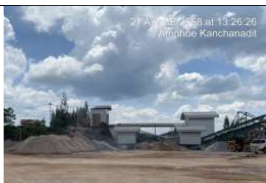
รูป W สร้างอาคารปิดคลุม Hopper, Primary Crusher และตระแกรงคัดขนาดแร่ พร้อมทั้งติดตั้งระบบสเปรย์น้ำ
