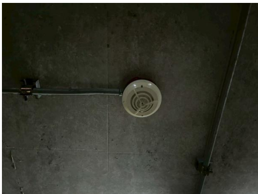
รูปที่ 2-8 เครื่องดักจับควัน
