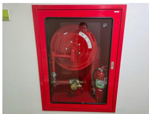
รูปที่ 2-33 ตู้เก็บสายดับเพลิงและถังดับเพลิง
