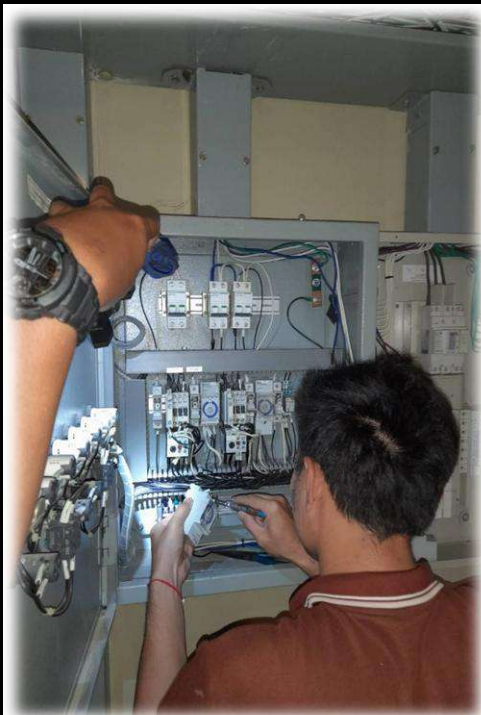
เปลี่ยนไทม์เมอร์สำหรับเปิดปิดไฟส่อง สว่างลานจอดรถของอาคารชุด
