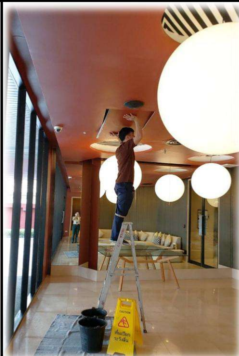
งานแก้ไขปัญหาน้ำหยดจากเครื่องปรับอากาศบริเวณลิโอบบี้ ชั้น G
