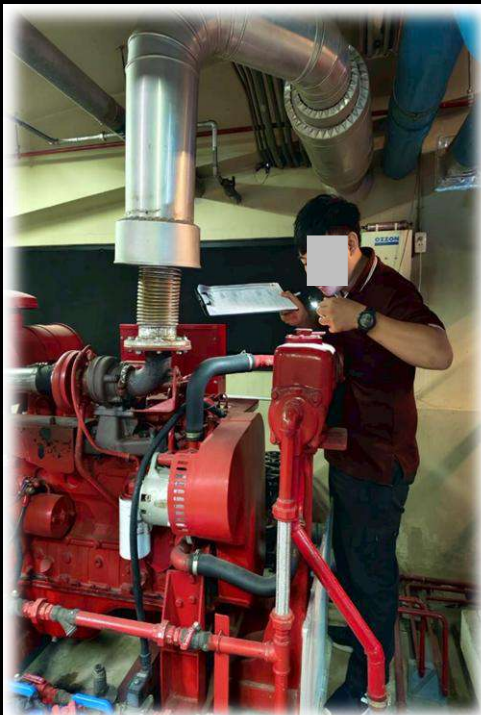
ตรวจเช็คและบำรุงรักษาระบบเครื่อง สูบน้ำดับเพลิงของอาคารชุด ชั้น G
