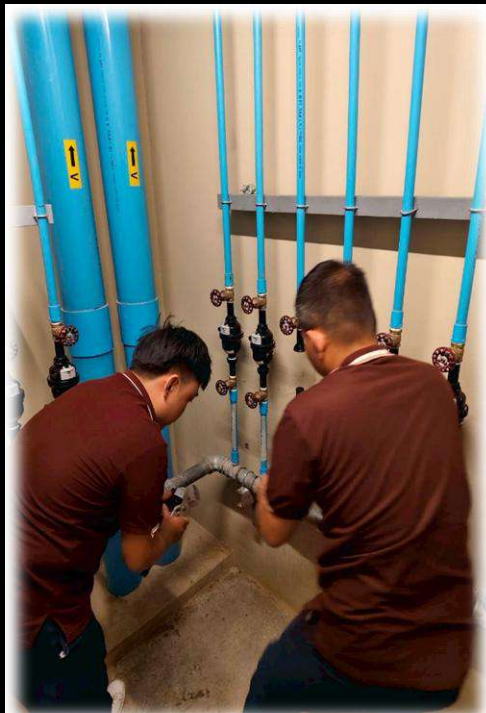
ซ่อมแก้ไขการรั่วซึมของท่อต่อมิเตอร์น้ำประปาของห้อง 8/59 และ 8/96
