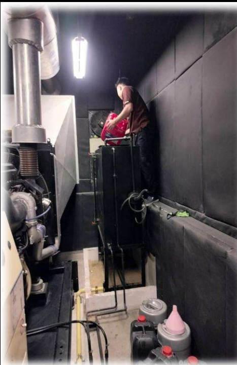
ตรวจเช็คและบำรุงรักษาระบบระบบ กำเนิดไฟฟ้าสำรองของอาคารชุด ชั้น G
