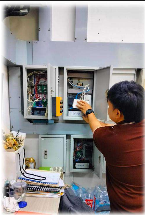
เปลี่ยนแบตเตอรี่สำหรับระบบควบคุม ไม้กั้นเข้าออกลานจอดรถของอาคารชุด
