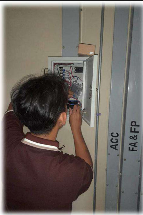
เปลี่ยนแบตเตอรี่สำหรับระบบประตูเข้า ออกของอาคารชุด
