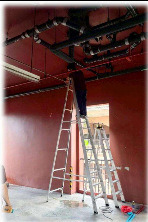
ติดตั้งวาล์วท่อน้ำดับบริเวณลานจอดรถ P4 สำหรับตรวจเช็คครอยรั่ว
