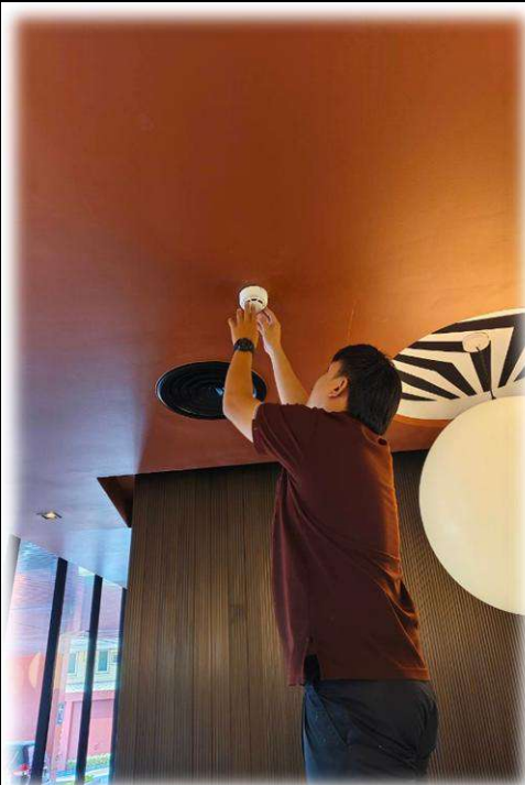
เปลี่ยนหัวตรวจจับควัน (Smoke Detector) บริเวณลิบบีชั้น G
