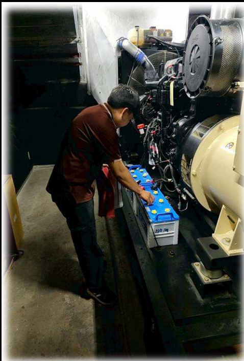
ตรวจเช็คและบำรุงรักษาระบบกำเนิด ไฟฟ้าสำรองของอาคารชุด ชั้น G
