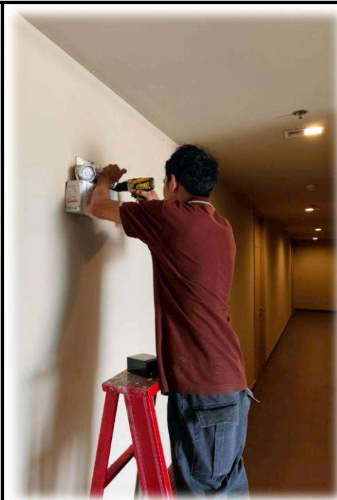
เปลี่ยนแบตเตอรี่ของไฟฉุกเฉินบริเวณโถงทางเดิน ชั้น 15
