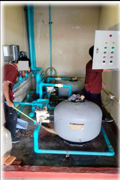
ตรวจเช็คและบำรุงรักษาระบบปั๊มน้ำ สระว่ายน้ำของอาคารชุด ชั้น 5
