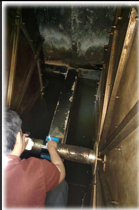
ตรวจเช็คและบำรุงรักษาระบบบำบัดน้ำ เสียของอาคารชุด ชั้น G
