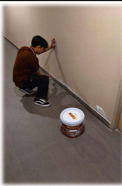
ซ่อมแซมบัวกระเบื้องโถงทางเดิน ส่วนกลางชั้น 16
