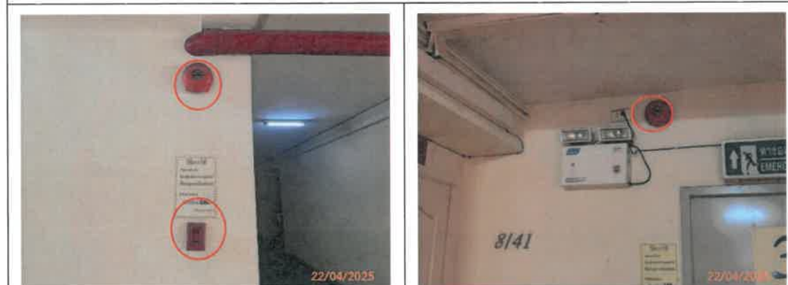
รูปที่ 14 ระบบสัญญาณเตือนเพลิงไหม้
