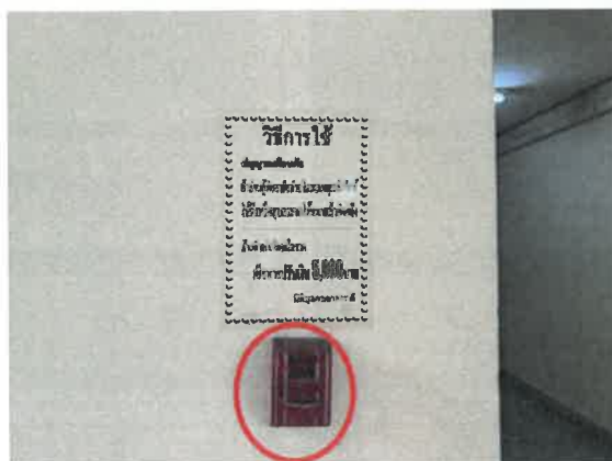
รูปที่ 1-7 อุปกรณ์แจ้งเหตุเพลิงไหม้แบบกด
