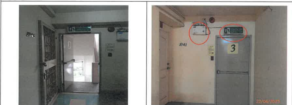
รูปที่ 16 ระบบหนีไฟ ได้แก่ บันไดหนีไฟ ระบบไฟฟ้าส่องสว่างสำรอง และป้ายบอกทางหนีไฟ
