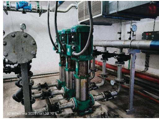
ถังเก็บน้ำชั้นใต้ดินและเครื่องปั้มน้ำชั้นใต้ดิน
