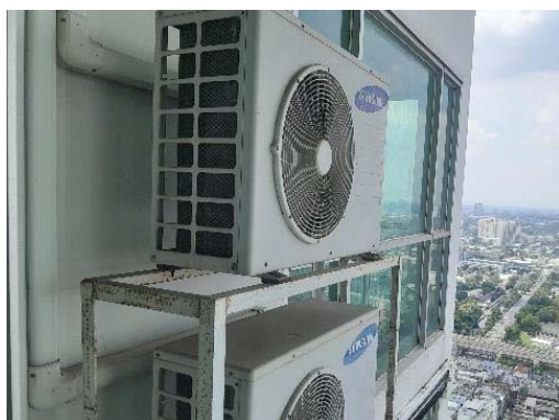
ระบบปรับอากาศแบบ Air Cooled Split Type
