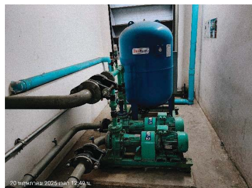
ถังเก็บน้ำ และ Booster Pump ชั้นดาดฟ้า
