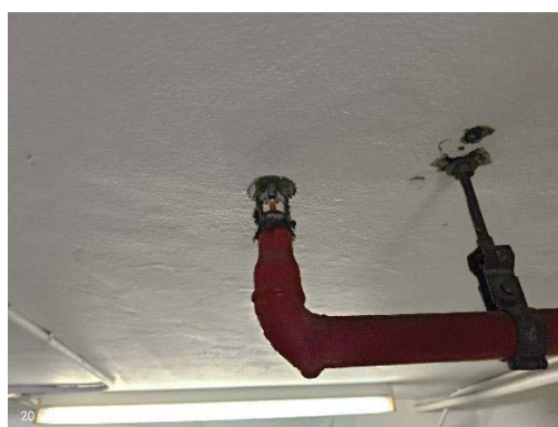
ระบบหัวจ่ายน้ำดับเพลิงอัตโนมัติ
