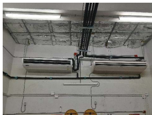
ระบบปรับอากาศแบบ Air Cooled Split Type
