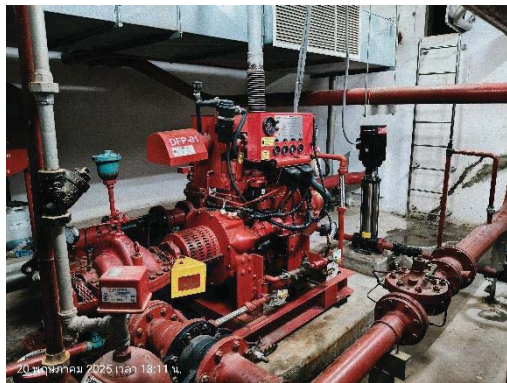
เครื่องปั้มน้ำดับเพลิงชั้นใต้ดิน
