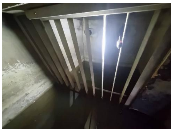
รูปที่ 2-44 จัดให้มีตะแกรงดักขยะก่อนระบายน้ำออกจากโครงการ
