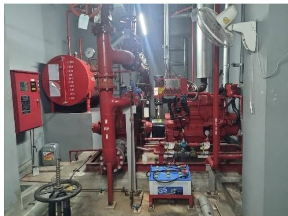
รูปที่ 2-48 ปั๊มน้ำดับเพลิง
