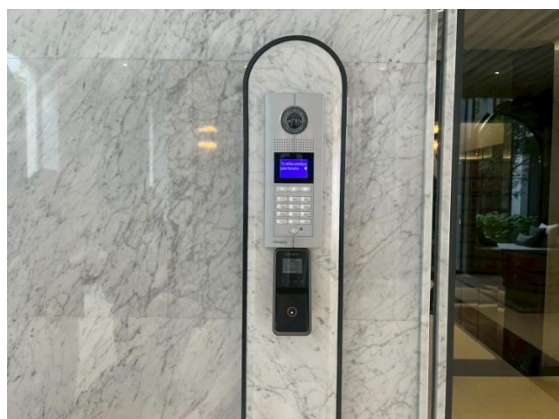
รูปที่ 2-24 ระบบควบคุมการเข้า-ออกอาคาร ด้วยระบบสแกนลายนิ้วมือและระบบคีย์การ์ด
