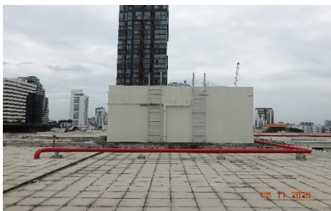
ถังเก็บน้ำชั้นดาดฟ้า และเครื่องปั๊มน้ำ
