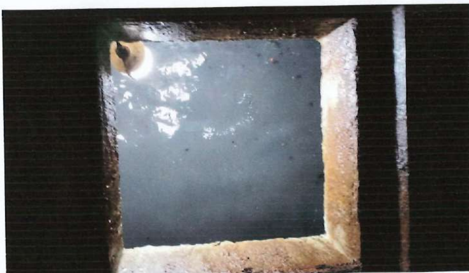
บ่อไขมัน 2 (Grease Trap Tank 2) หลังทำเสร็จ
