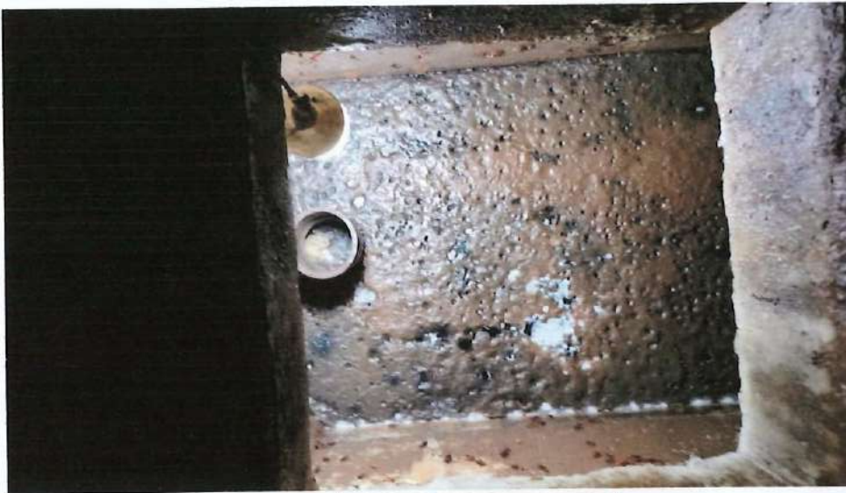
บ่อไขมัน 3 (Grease Trap Tank 3) ขณะกำลังทำ
