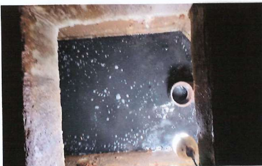
บ่อไขมัน 3 (Grease Trap Tank 3) หลังทำเสร็จ
