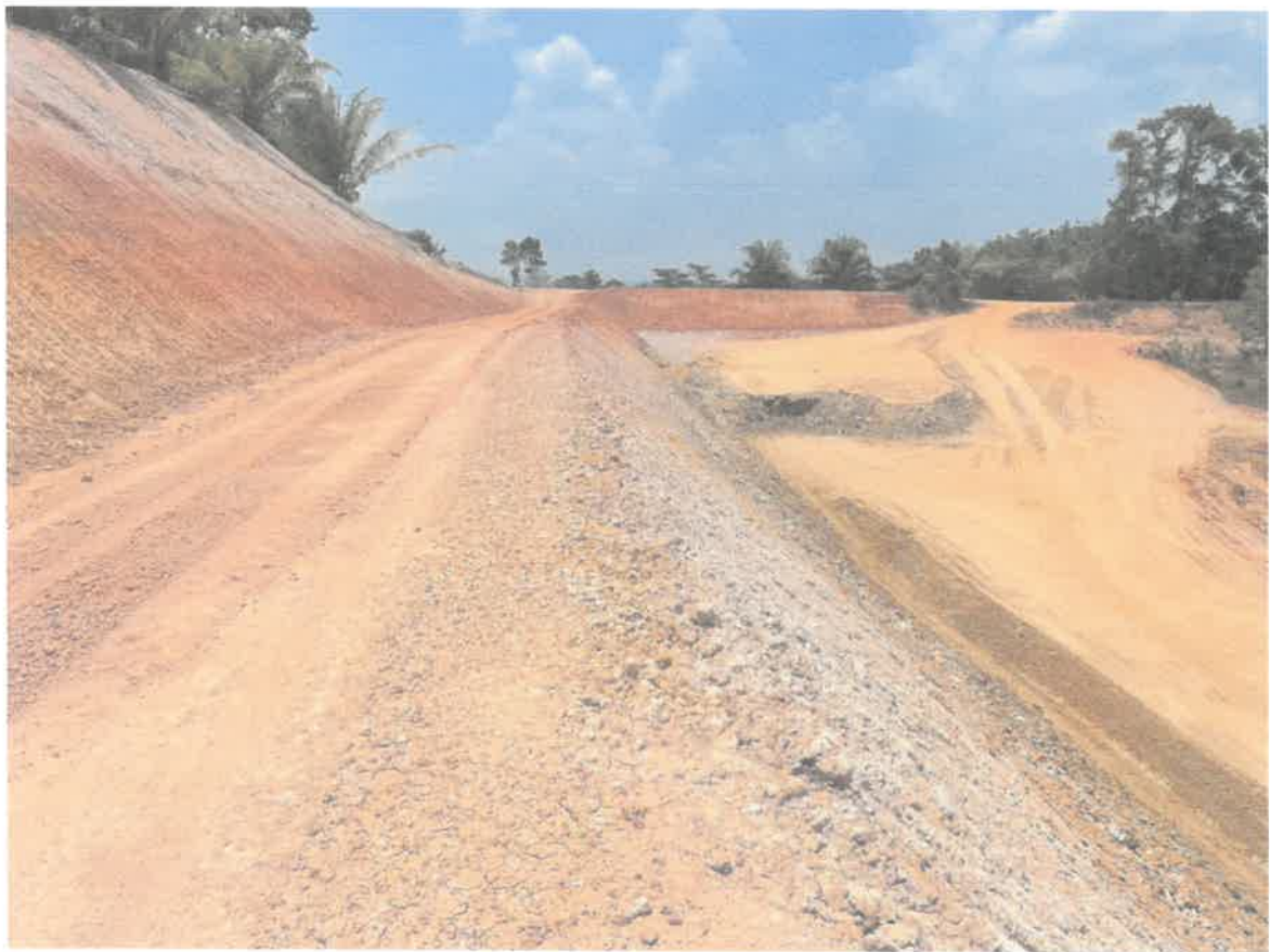
การปรับปรุงภาพขอบบ่อเหมืองให้มีเสถียรภาพสอดคล้องตามแผนผังโครงการทำเหมือง
