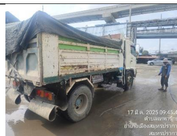
รูปที่ ๗7.9 การล้างล้อรถก่อนออกนอกเขตรื้อถอน
