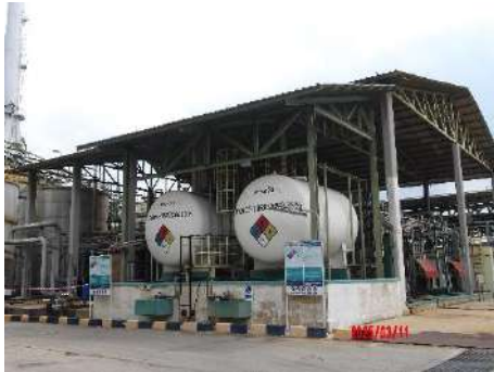
ภาพที่ 2.2-16 Dike สำหรับกักเก็บสารเคมีและถังสำรองเชื้อเพลิง
