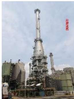
ภาพที่ 2.2-21 ระบบ Sea Water Scrubber
