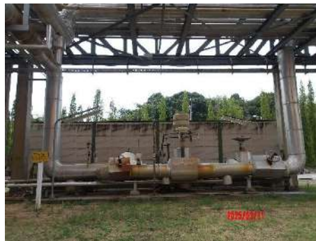
ภาพที่ 2.2-42 ระบบฉนวนป้องกันความร้อน และการปิดคลุมที่แหล่งกำเนิดความร้อน
