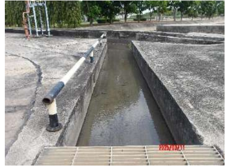
ภาพที่ 2.2-20 ร่องน้ำขนาดกว้าง 2 เมตร ลึก 1.5-2 เมตร ล้อมรอบกองถ่านหิน
