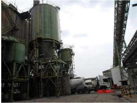
ภาพที่ 2.2-32 ไซโลเก็บเถ้าแบบปิด
