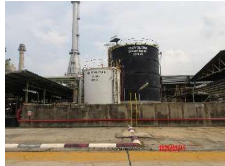
ภาพที่ 2.2-16 Dike สำหรับกักเก็บสารเคมีและถังสำรองเชื้อเพลิง
