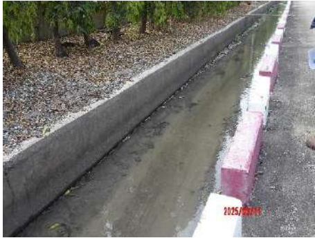
ภาพที่ 2.2-20 ร่องน้ำขนาดกว้าง 2 เมตร ลึก 1.5-2 เมตร ล้อมรอบกองถ่านหิน
