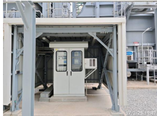
เครื่องตรวจวัดคุณภาพอากาศจากปล่องอย่างต่อเนื่อง (CEMS) ของปล่อง HRSG 32
