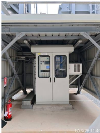
เครื่องตรวจวัดคุณภาพอากาศจากปล่องอย่างต่อเนื่อง (CEMS) ของปล่อง HRSG 31
