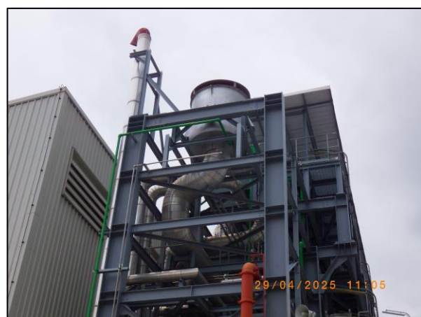
รูปที่ 2.17 อุปกรณ์ลดเสียง Silencer
