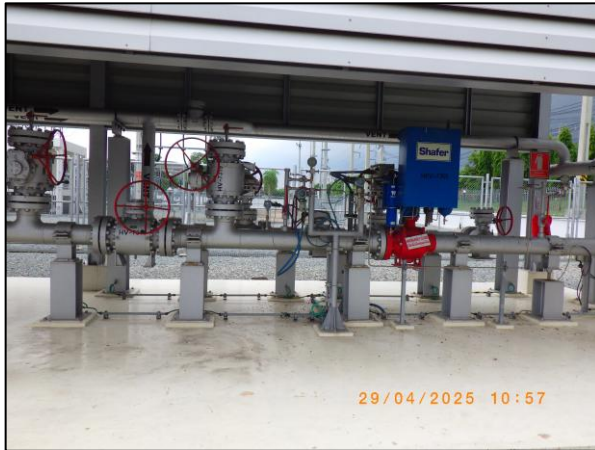
รูปที่ 2.42 ระบบท่อ By Pass และระบบวาล์วลำรอง (ต่อ)
