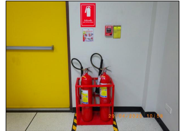
รูปที่ 2.44 อุปกรณ์ดับเพลิงชนิดผงเคมีแห้ง สถานีควบคุม บริเวณ Metering/Gate station
