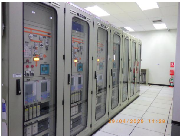
รูปที่ 2.45 ระบบป้องกันทางไฟฟ้า (Transformer Protection)
