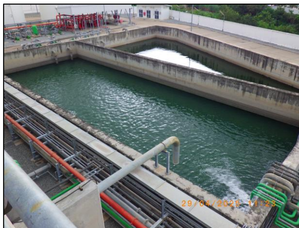
รูปที่ 2.11 บ่อพักน้ำทิ้งฉุกเฉิน (Emergency Pit)
