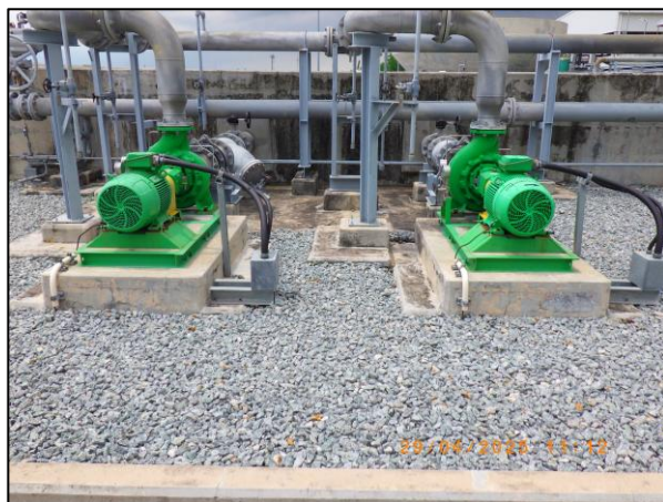
รูปที่ 2.16 ฐานคอนกรีตลดแรงสั่นสะเทือน
