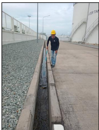
รูปที่ 2.22 การทำความสะอาดรางระบายน้ำ และท่อระบายน้ำ
