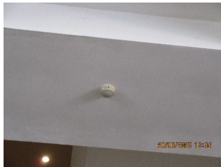
ระบบตรวจจับควัน (Smoke Detector)
