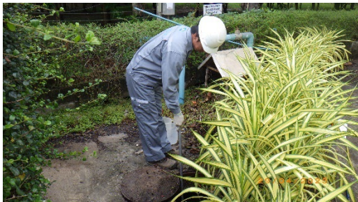
บ่อพัก (Manhole) ของน้ำล้นจากบ่อดักตะกอน
