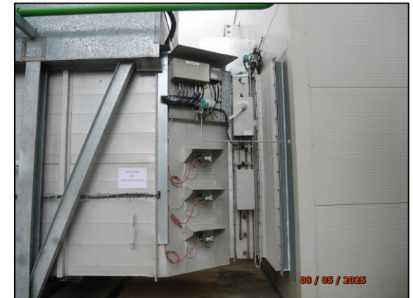
รูปที่ 2.28 ระบบป้องกันการรั่วซึมของก๊าซ (Gas Detector บริเวณ Gas Turbine)
