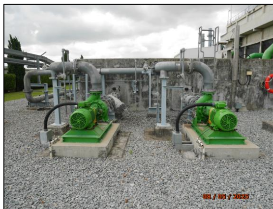
รูปที่ 2.9ฐานคอนกรีตลดแรงสั่นสะเทือน
