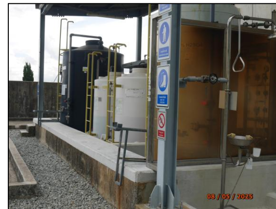
รูปที่ 2.37 คันคอนกรีตรอบถังเก็บสารเคมี
