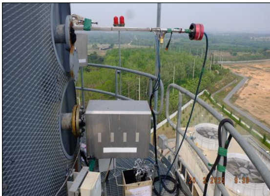
รูปที่ 3.1 การเก็บตัวอย่างคุณภาพอากาศในปล่องระบาย บริเวณ ปล่องหน่วยผลิตไอน้ำ HRSG 41
