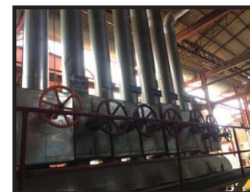
12. เปิดวาล์ว จากเฮดเดอร์แผ่นกหม้อไอน้ำ
