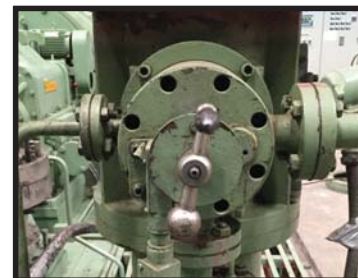
17. เปิดวาล์ว ESV เพื่ออุ่นเครื่องเทอร์โบไนน์
