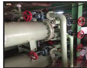
15. เปิดวาล์วน้ำระบายความร้อนของน้ำมันหล่อลื่น
