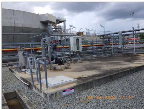
รูปที่ 2.16 ป่อปรับสภาพความเป็นกรด-ด่าง (Neutralization Pit)
