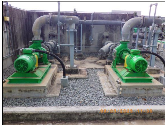
รูปที่ 2.9 ฐานคอนกรีตลดแรงสั่นสะเทือน
