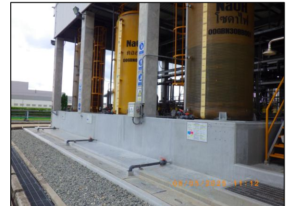
รูปที่ 2.37 คันคอนกรีตรอบถังเก็บสารเคมี
