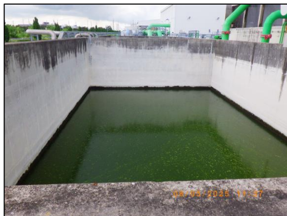
รูปที่ 2.15 ป่อพักน้ำทิ้งฉุกเฉิน (Emergency Pit)
