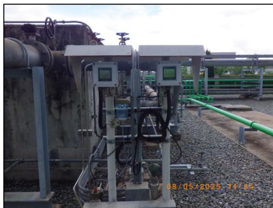
รูปที่ 2.14 เครื่องตรวจวัดคุณภาพน้ำแบบอัตโนมัติ
