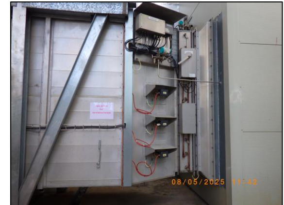
รูปที่ 2.28 ระบบป้องกันการรั่วซึมของก๊าซ (Gas Detector บริเวณ Gas Turbine)
