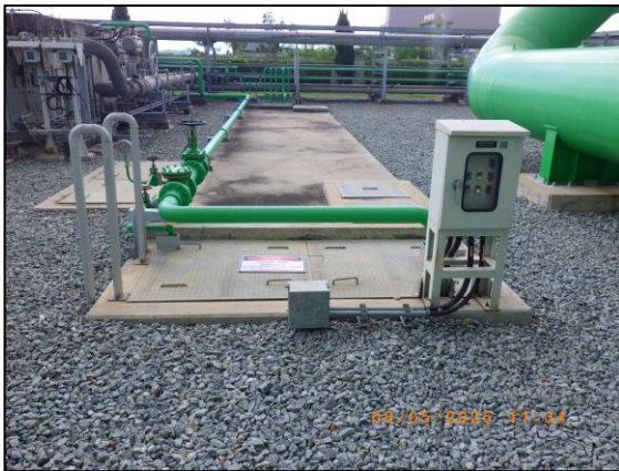
รูปที่ 2.18 ป่อแยกน้ำมัน (Oil Separator)
