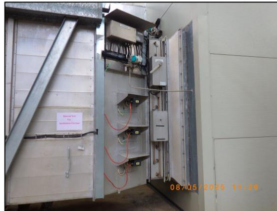
รูปที่ 2.28 ระบบป้องกันการรั่วซึมของก๊าซ (Gas Detector บริเวณ Gas Turbine)
