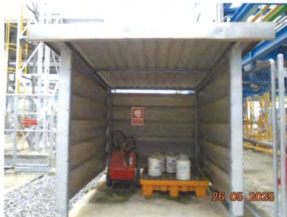
ภาพที่ 2.2-40 ถังฉีดโฟมเคลื่อนที่ (Mobile Foam Unit)
