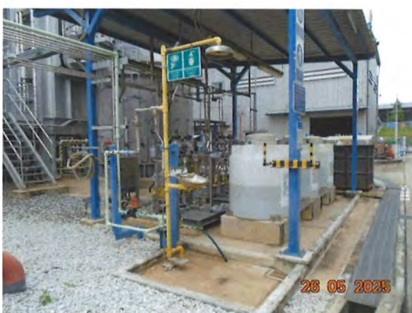
ภาพที่ 2.2-32 อุปกรณ์ชำระล้างฉุกเฉิน (Emergency Shower and Eye Wash Fountain)
