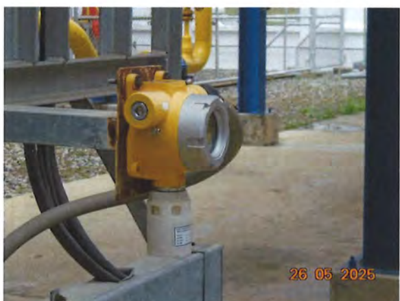
ภาพที่ 2.2-31 ระบบป้องกันการรั่วซึมของก๊าซ (Gas Detector)
