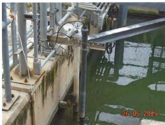
ภาพที่ 2.2-13 Level Switch บริเวณบ่อกักน้ำทิ้ง
