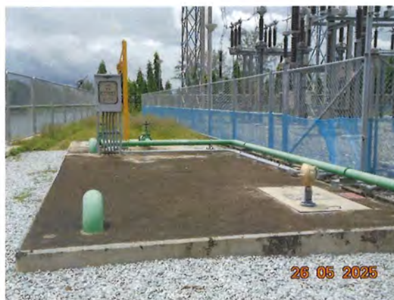
ภาพที่ 2.2-15 ถังแยกน้ำและน้ำมัน
