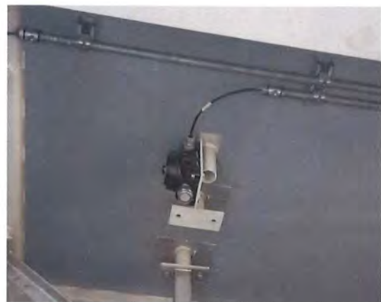
ภาพที่ 2.2-39 เครื่องตรวจจับการรั่วไหลของก๊าซธรรมชาติ
