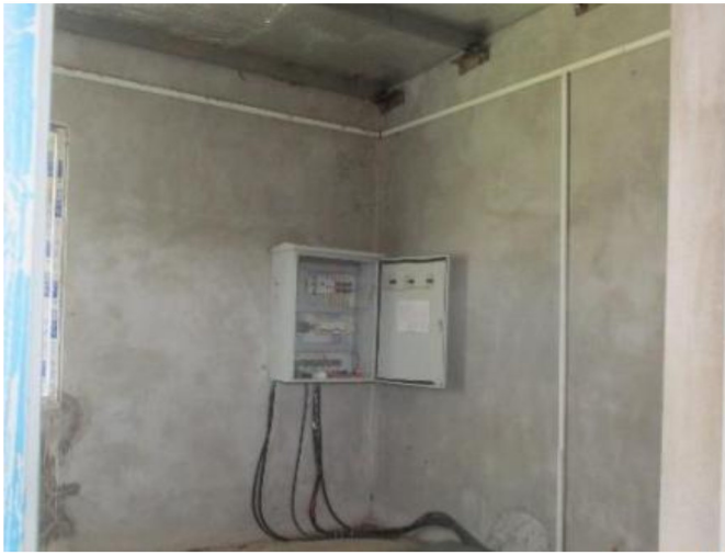
ภาพที่ 3-5 ระบบควบคุมระบบน้ำเสีย
