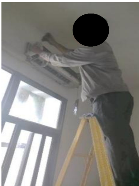
ภาพที่ 3-17 การทำความสะอาดเครื่องปรับอากาศ
