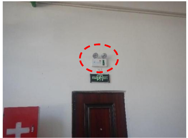
ภาพที่ 3-16 ไฟส่องสว่างฉุกเฉิน
