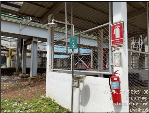
รูปที่ 2-46 อ่างล้างตาและฝักบัวชำระร่างกาย
