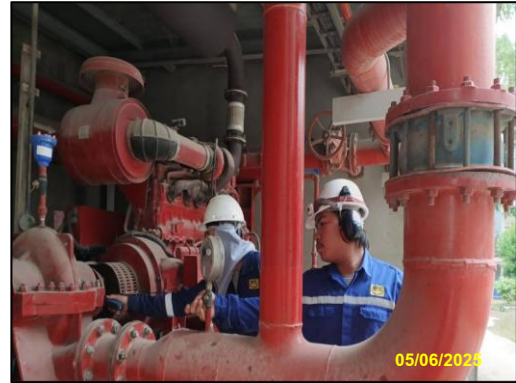
รูปที่ 2-53 ตัวอย่างการตรวจสอบประสิทธิภาพอุปกรณ์ ดับเพลิงของโครงการ
