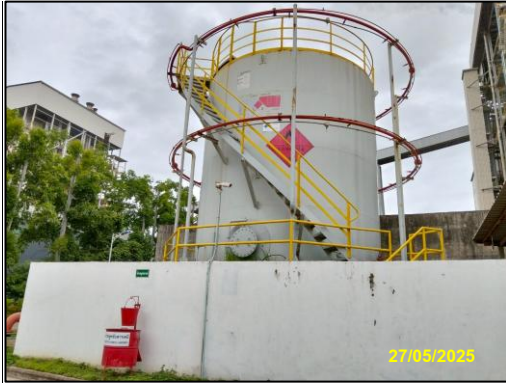
รูปที่ 2-16 คั่นคอนกรีตล้อมรอบลานถังก๊าซไนโตรเจน
