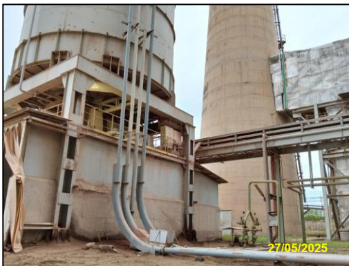
รูปที่ 2-9 ระบบลำเลียงเถ้าจากหน่วยการผลิตเข้าสู่ไซโล
