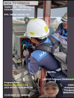
รูปที่ 2-2 ตัวอย่างงานซ่อมบำรุงระบบหล่อเย็น
