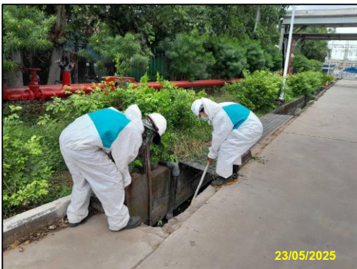
รูปที่ 2-20 การขุดลอกตะกอนรางระบายน้ำ
