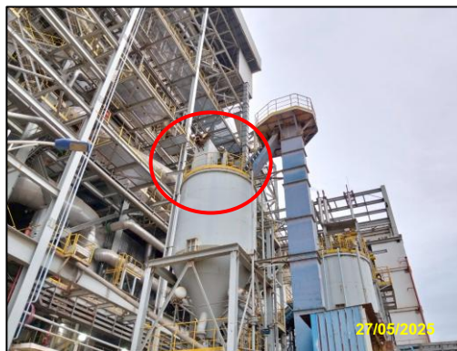
รูปที่ 2-57 การติดตั้ง Rapture Disk หรือ Safety Vent
