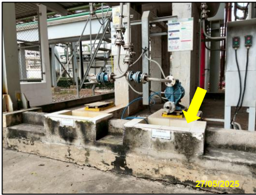
รูปที่ 2-44 เชื้อนป้องกันการรั่วไหลรอบถังบรรจุสารเคมี
