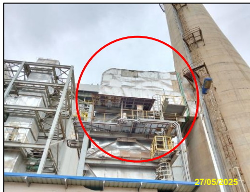
รูปที่ 2-3 ตำแหน่งที่ติดตั้งเครื่องตรวจวัดความเข้มข้นของมลพิษทางอากาศจากปล่องแบบอัตโนมัติอย่างต่อเนื่อง (CEMs)
