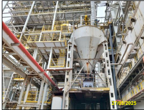
รูปที่ 2-34 ถังเก็บเถ้าหนัก (Bottom Ash Silo)
