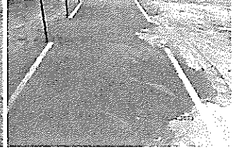
สภาพทั่วไป และรอยแตกร้าวบริเวณพื้นคอนกรีต
