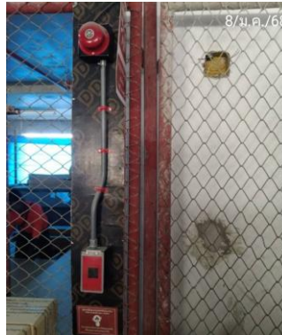
รูปที่ 52 เครื่องแจ้งเหตุเพลิงไหม้
