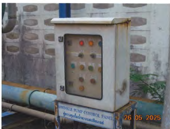
ภาพที่ 2.2-26 ตู้ควบคุมปั๊มน้ำทิ้งกลับมาใช้รดน้ำต้นไม้
