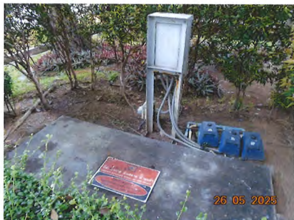
ภาพที่ 2.2-25 ระบบบำบัดน้ำเสียสำเร็จรูป (Septic Tank)
