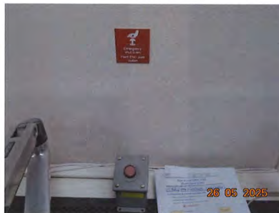
ภาพที่ 2.2-56 ปุ่ม Emergency shutdown
