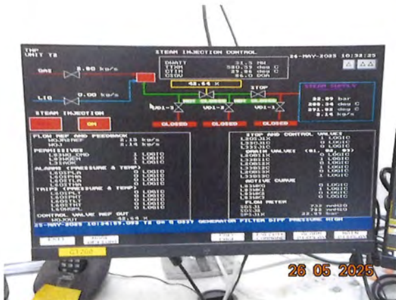
ภาพที่ 2.2-6 หน้าจอควบคุม NOx โดยใช้ steam injection system
