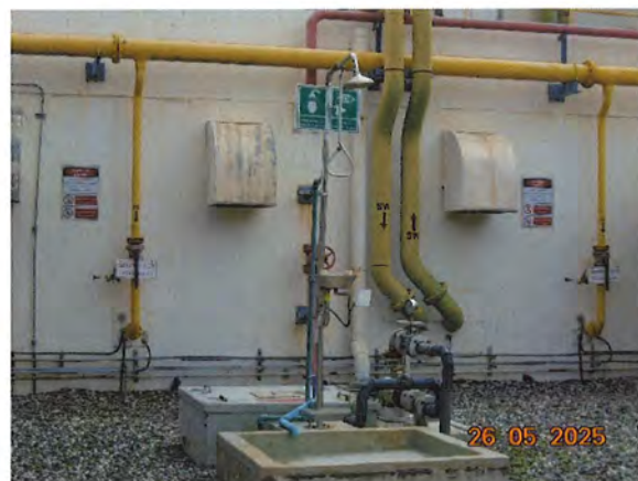
ภาพที่ 2.2-50 อ่างล้างตาฉุกเฉินและ ฝักบัวฉุกเฉิน
