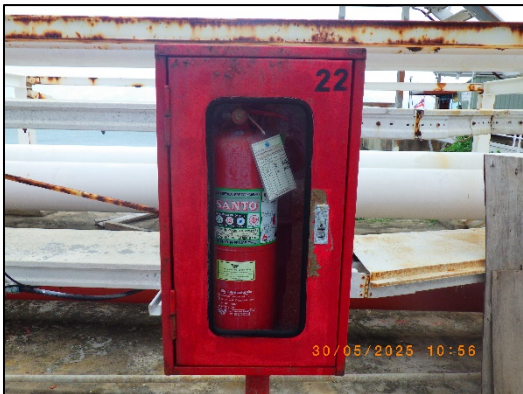
ถังดับเพลิงชนิดผงเคมีแห้งแบบติดตั้งประจำ
