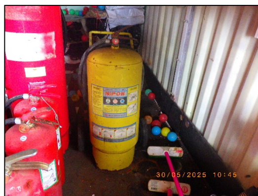
ถังบรรจุโฟมเหลวพร้อมหัวฉีดเคลื่อนย้ายได้
