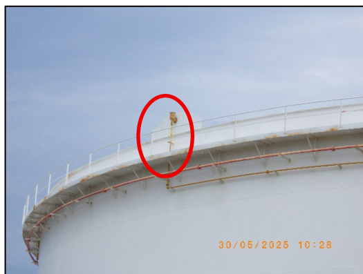
ระบบ Fixed Foam สำหรับถังเก็บน้ำมัน
