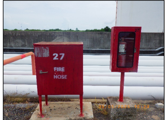
รูปที่ 2.9 ระบบดับเพลิงภายนอกอาคาร ใช้ไฟมสำหรับดับเพลิง (ต่อ)
