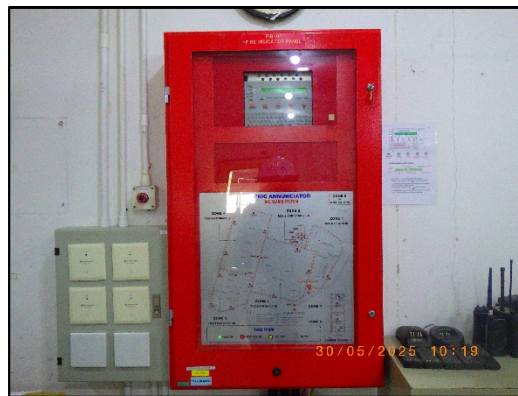
Fire Indicator Panel แผงแสดงตำแหน่งจุดเกิดเพลิงไหม้ในอาคาร รูปที่ 2.11 ระบบดับเพลิงภายในอาคาร และระบบแจ้งเตือน (ต่อ)
