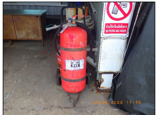
ถังดับเพลิงชนิดผงเคมีแห้งแบบเคลื่อนย้ายได้
