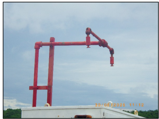
ระบบ Fixed Water Monitor
