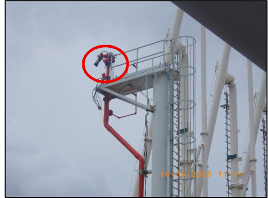
ระบบ Fixed Water Monitor
