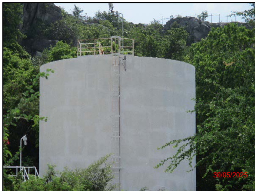
รูปที่ 2.3 Ballast Tank ความจุ 1,000 m 3 เพื่อรองรับน้ำเสีย น้ำมันปนเปื้อน และน้ำทิ้งที่เกิดจากการทำความสะอาดน้ำมันที่รั่วไหลลงสู่พื้นท่าเรือ
