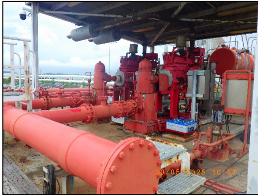
เครื่องยนต์ขับเคลื่อนน้ำดับเพลิงชนิดทวนน้ำทะเล
