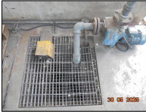
รูปที่ 8 ป่อ Neutralisation เพื่อรวบรวมน้ำระบายทิ้งจากระบบหล่อเย็นและหม้อต้มไอน้ำ
